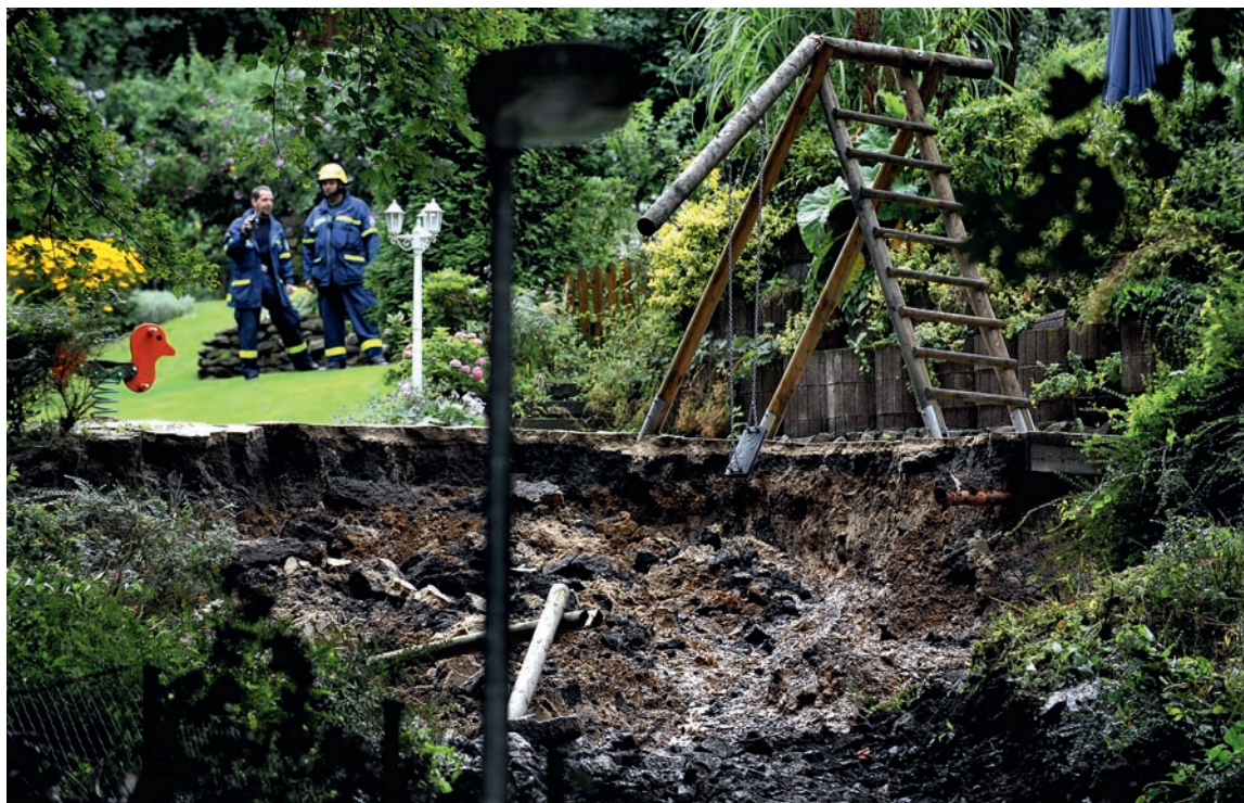
Garten zerstört: Schäden sind nicht durch die Gebäudeversicherung gedeckt
