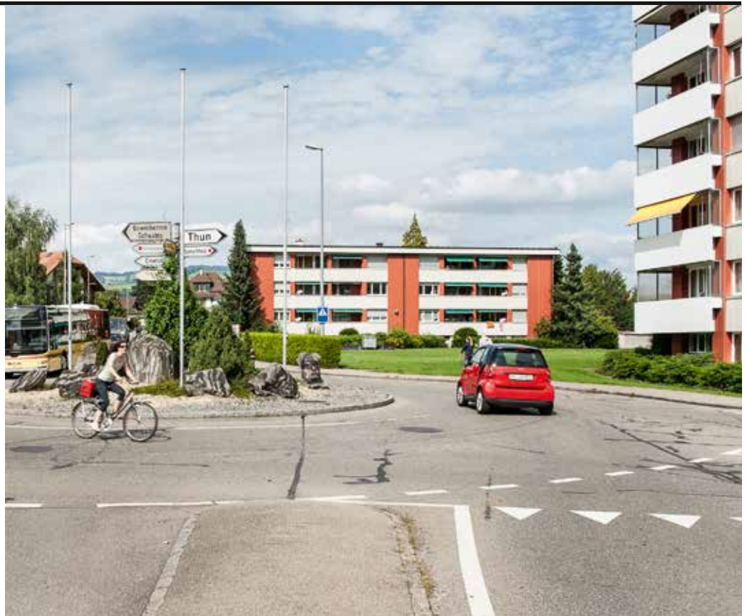
Gefährlicher Kreisel in Steffisburg BE: Einmündung zielt zu weit am Mittelpunkt vorbei
